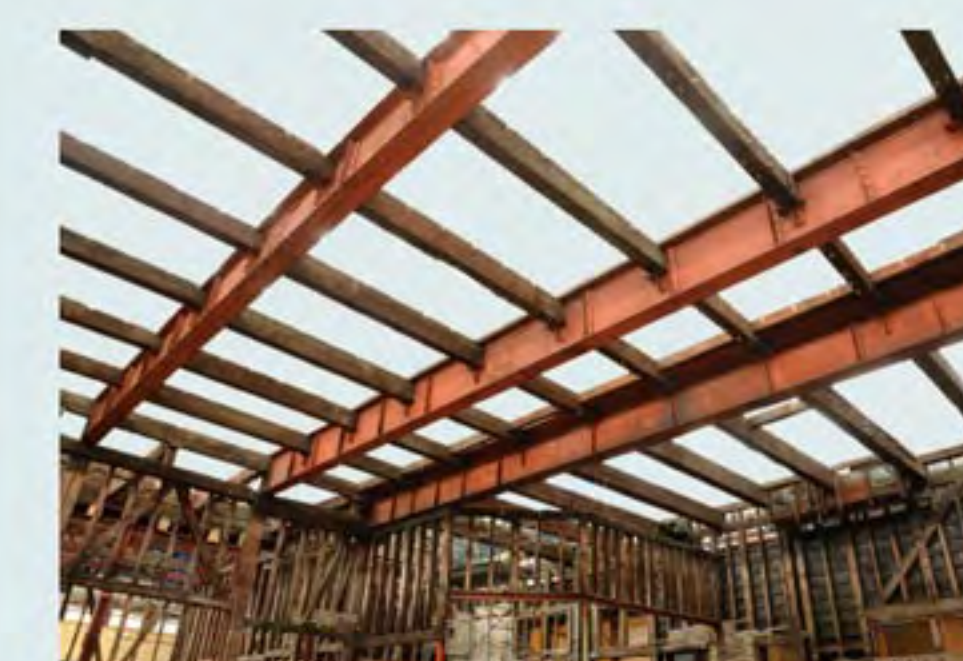
コンコースの天井裏にある鉄骨梁
