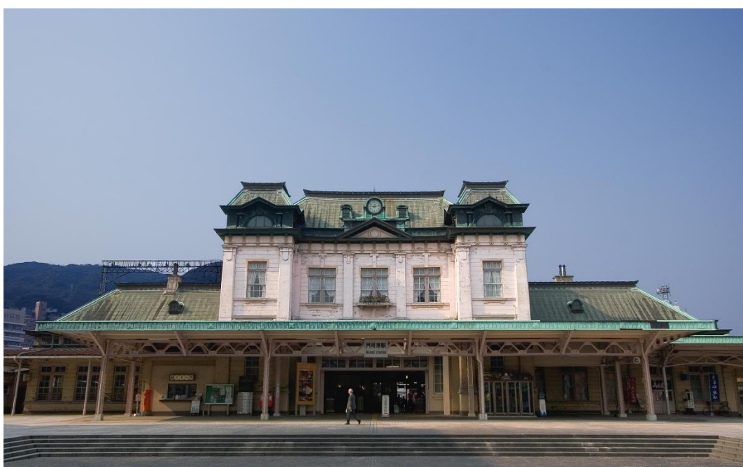
修理工事着手前
